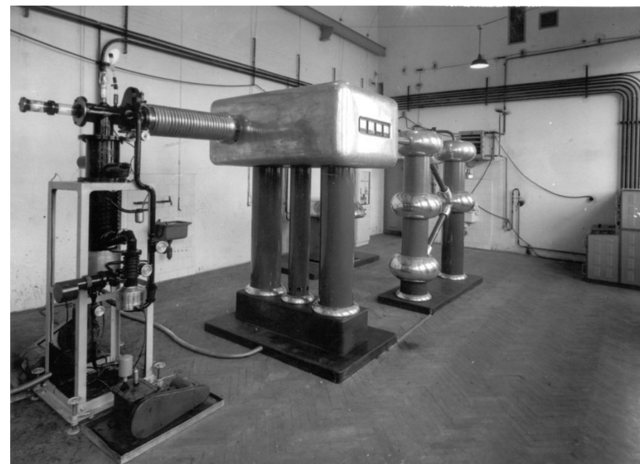
Az első gyorsítók egyike: deutérium ionok neutronokat keltenek
